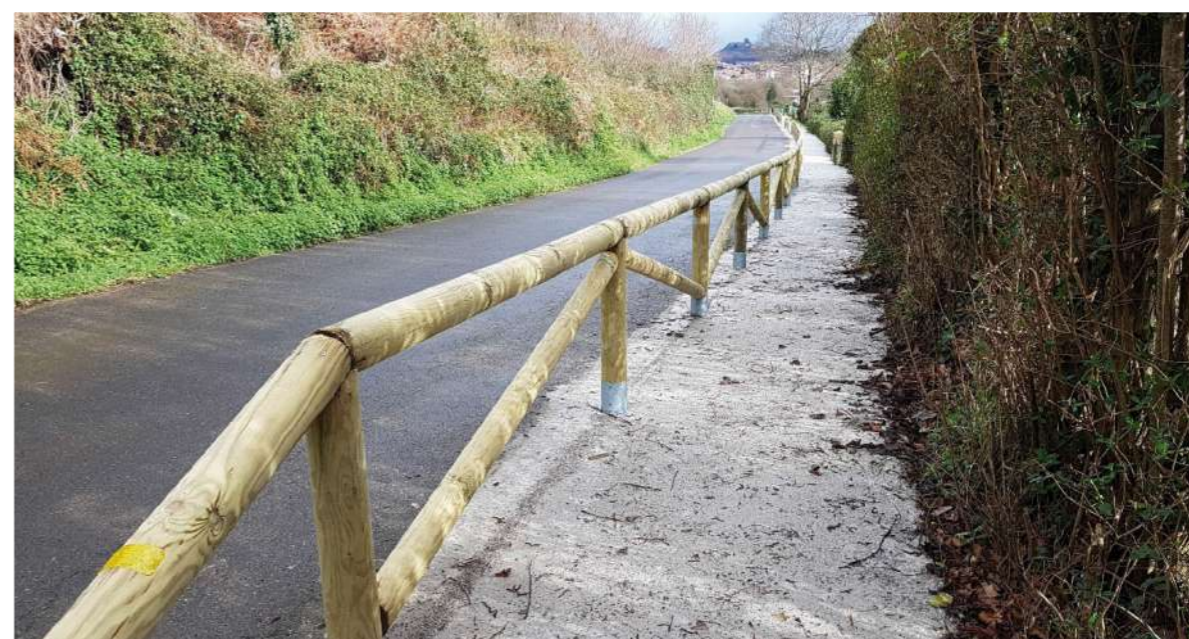
Tramo del camino en la carretera a San Pedro, recientemente inaugurado/PV
