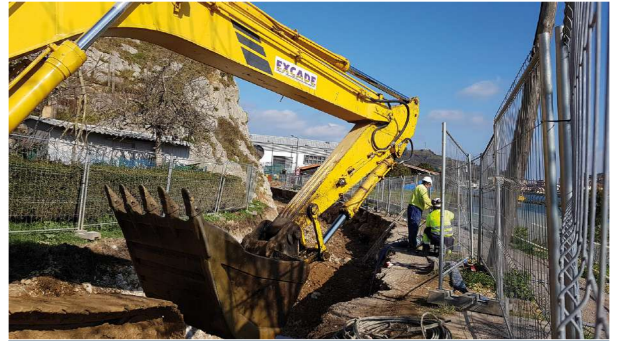
Obras en el Picu Ramonón (RS-2)/PV
