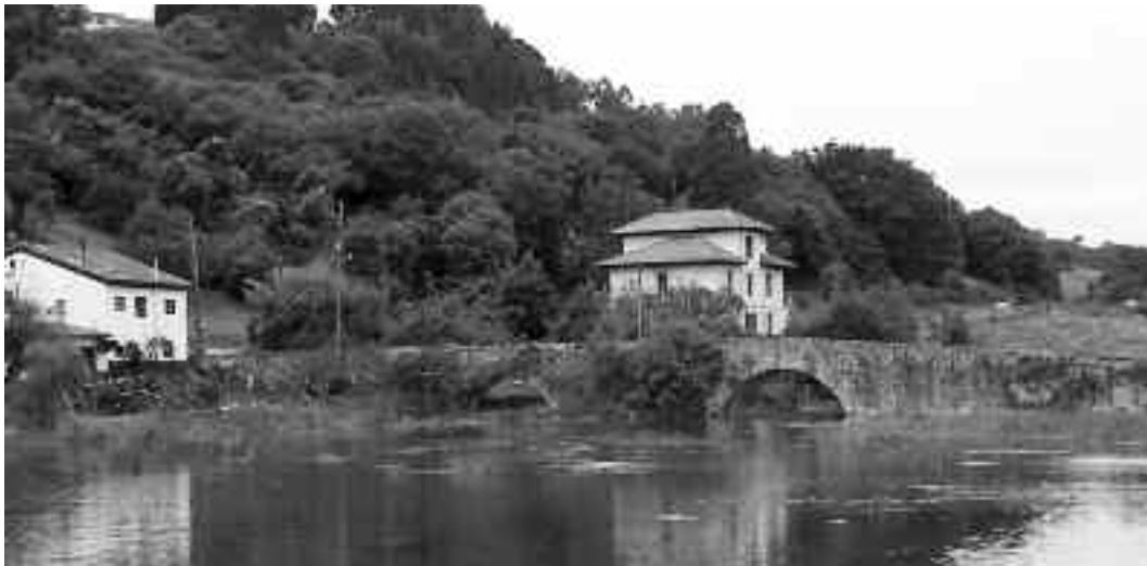
En 1842 fue reparado el puente del Pilar.
