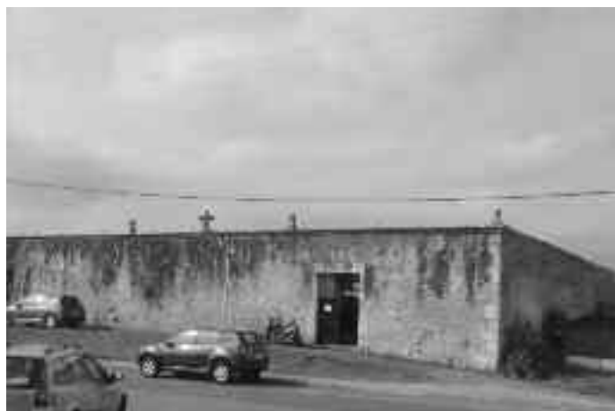
Fachada principal del cementerio municipal de la villa.
