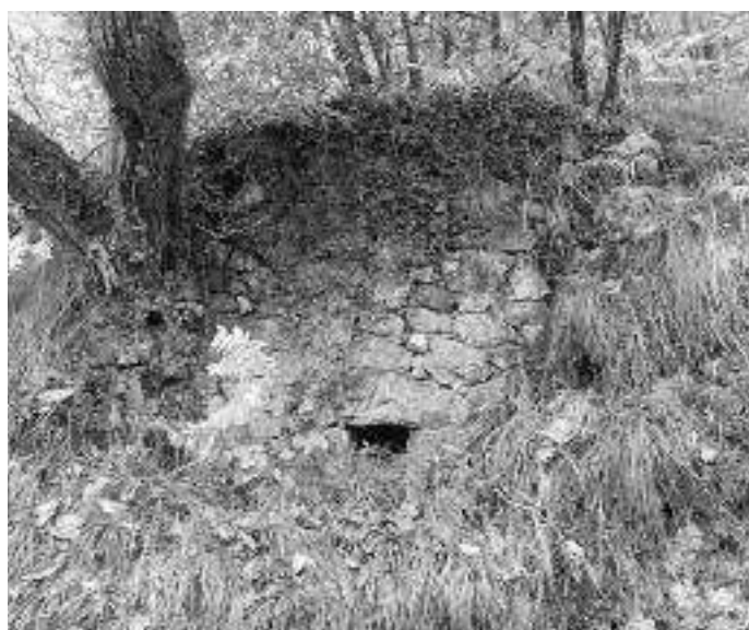
Calero de La Riega'l Cubil (Nocéu). Fachada exterior.
