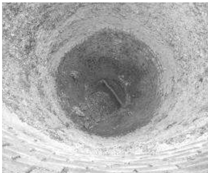
Vientre del calero-2 de Sebreñu. En la foto se advierten lo que queda de la parrilla de hierro que sostenía la carga.
