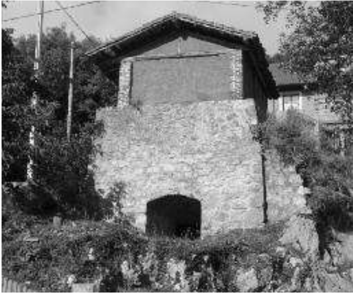
Calero-1 de Sebreñu. La construcción superior es ajena al horno industrial.
