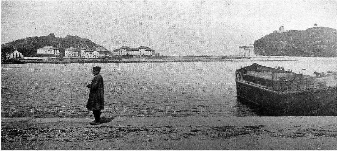
Panorámica desde el muelle en 1921, de un tiempo que se fue. En primer plano un niño y la gabarra utilizada en las obras portuarias. Al fondo, el chalet de los marqueses de Argüelles, los chalets adosados, los chalets gemelos en parte ocultos por la fábrica de Izaurieta, el chalet de Pidal, entonces conocido como Villa Oseja y hoy residencia, y sobresaliendo por encima de la antigua fábrica de Suárez, el desaparecido edificio de la Vecindad Vieja; también la fábrica de sidra. A lo lejos, los montes de Guía y Somos.
