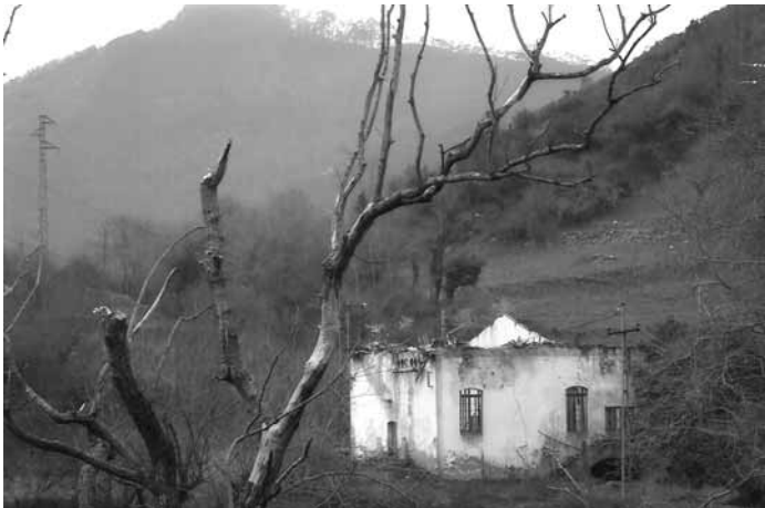
Restos de la "Eléctrica del Sella".
