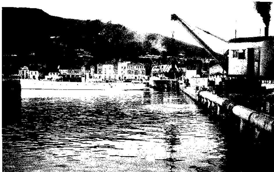
En junio de 1934 se instaló una grúa de vapor, traída desde El Musel, para carga y descarga de buques.
