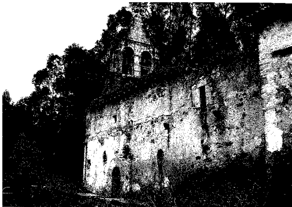
Fachada meridional de la nave/PV
