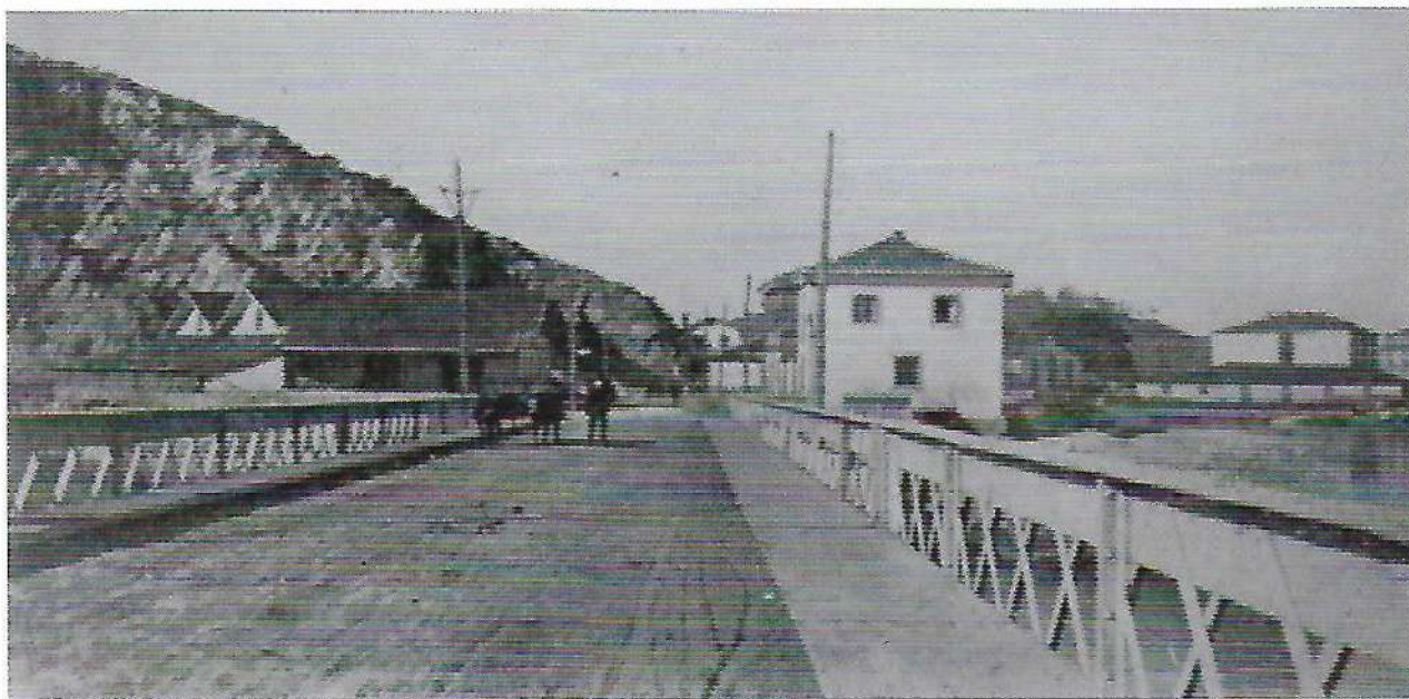
El puente de hierro (1919).
