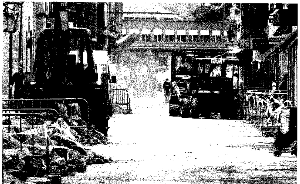
Obras de remodelación de la calle del Comercio/PV
