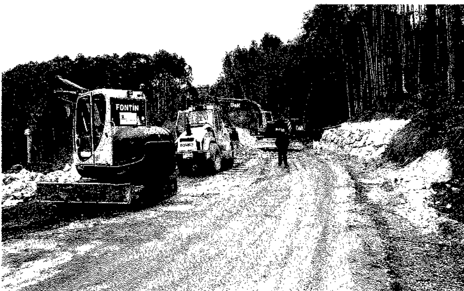
Obras de ensanche de la carretera a Tereñes/CR
