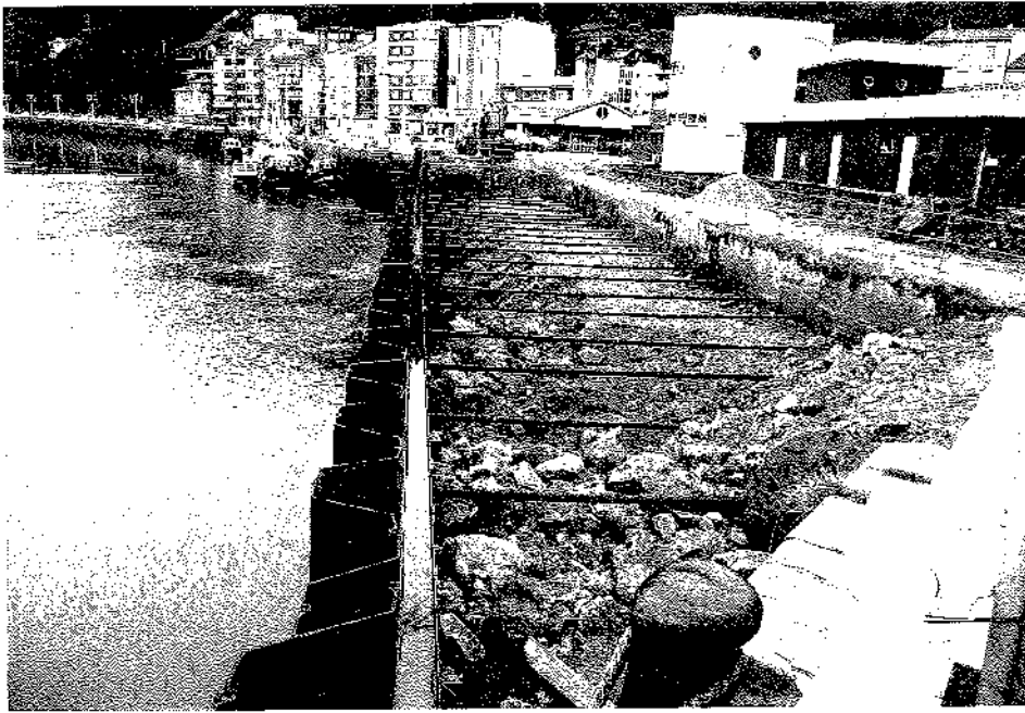
Las obras del muelle prosiguen a buen ritmo /PV
