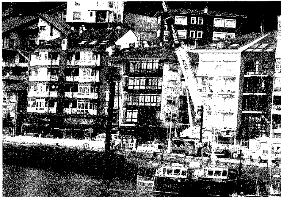
Colocación de la primer tablestaca en los muelles huecos del puerto/PV
