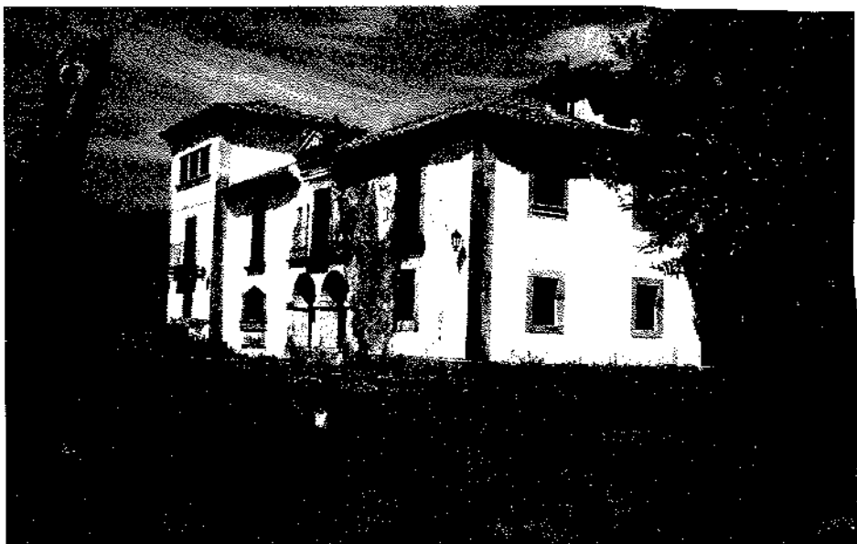
El Palacio de Linares hoy, con algún pequeño deterioro en la fachada a punto de subsanarse. A la izquierda el centenario roble, vencido por una ventolera hace unos años.
