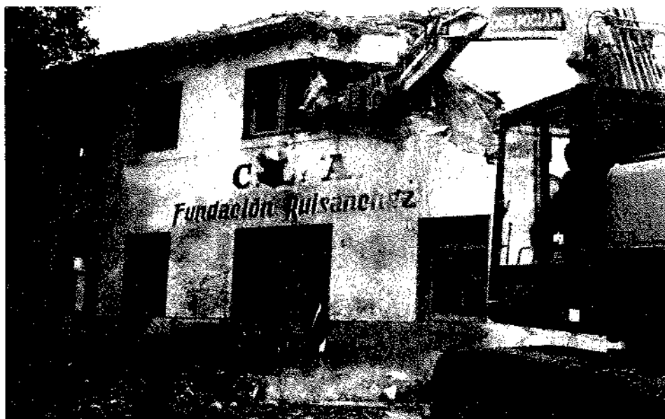
Fachada del «Instituto» en el momento de su demolición
