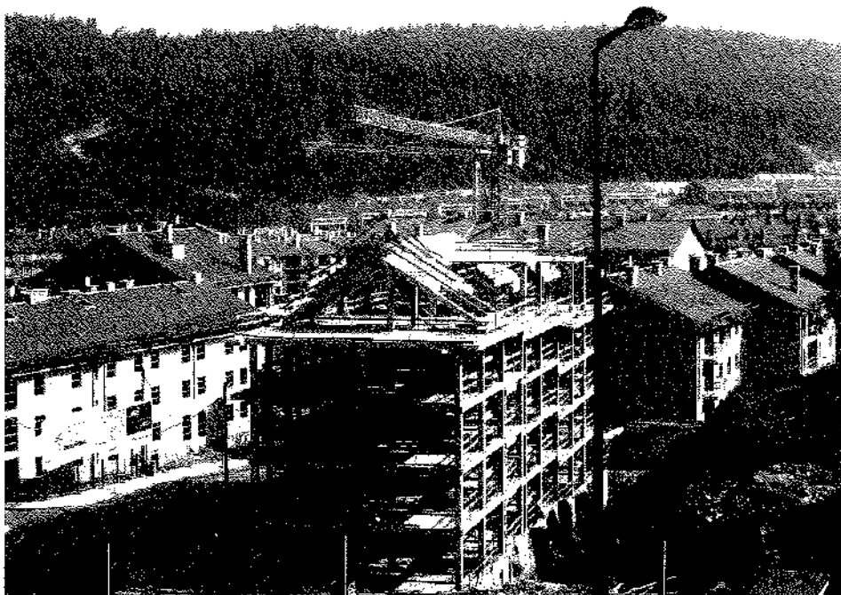
Construcciones en Los Porqueros
