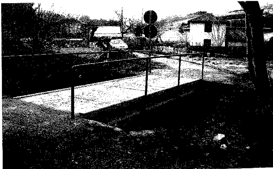
Puente provisional en San Miguel de Ucio tras ser derruido el existente
