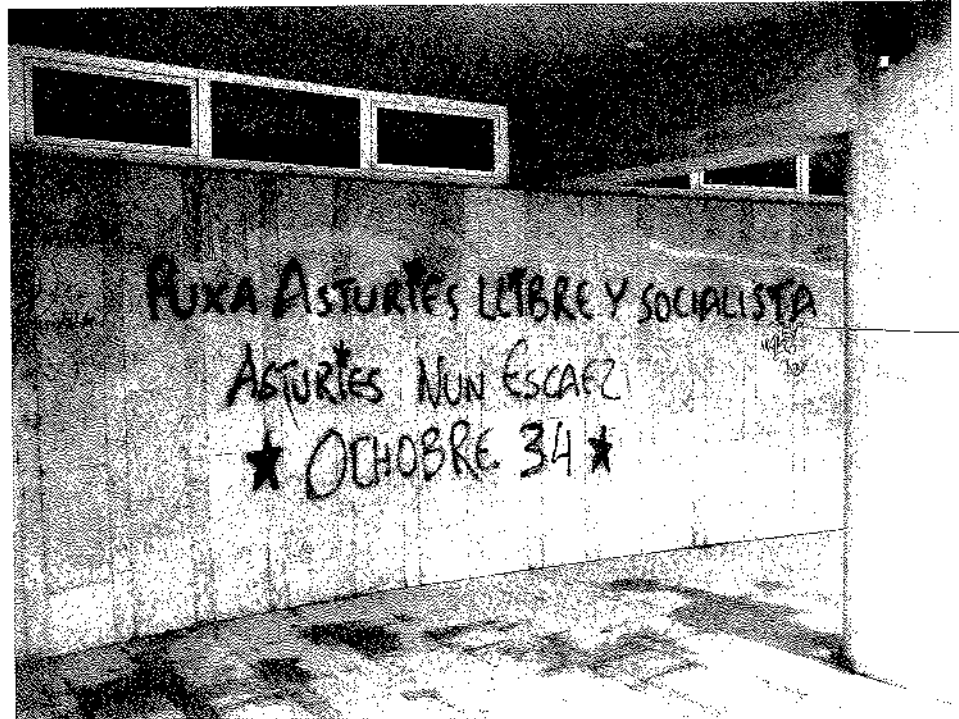
Casa de la Contracultura
