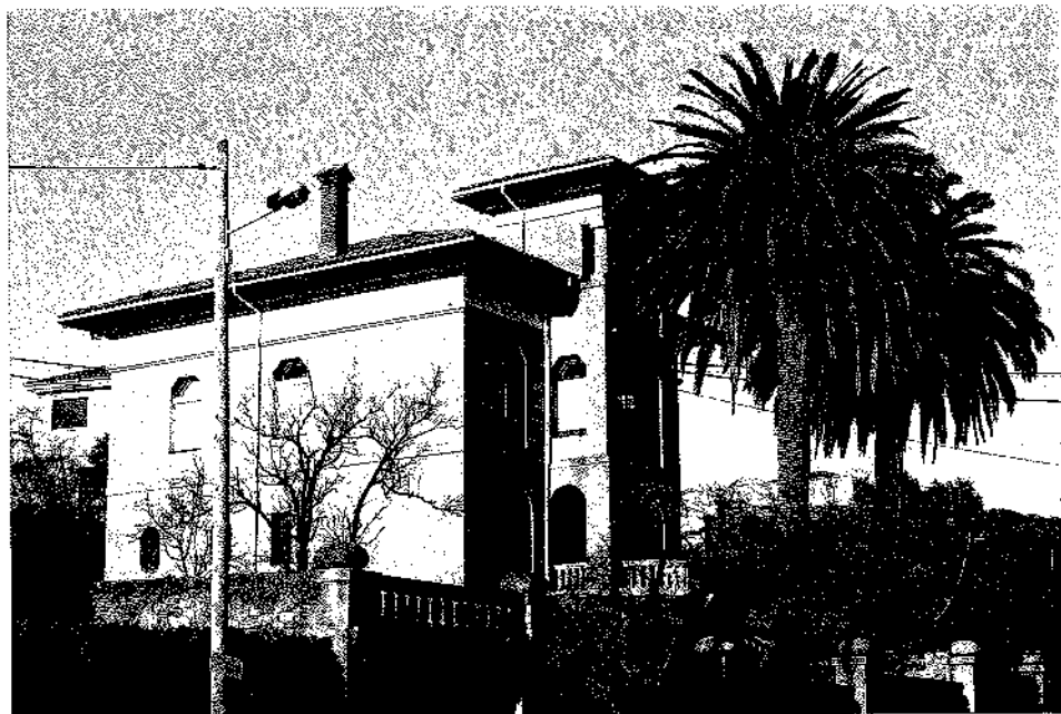
Villa Josefina, levantada en Berbes por Manuel Prieto. El proyecto se debe al arquitecto Miguel García-Lomas y es idéntico a Villa Argentina, en Santa Marina
