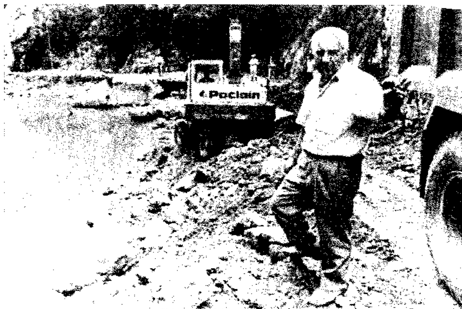
El alcalde Juan Ureta inspecciona las obras de la carretera a Vega tras el desastre (1988)
