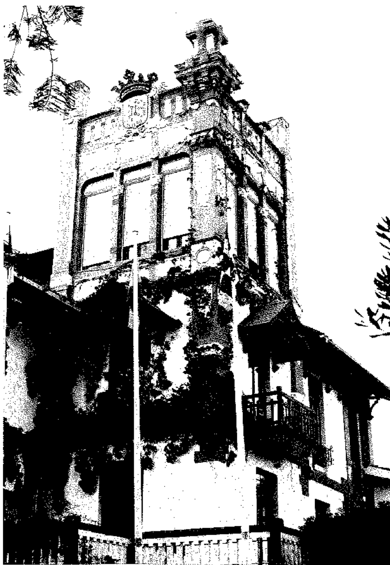
Detalle de la influencia de la arquitectura inglesa en el chalet de la marquesa de Argüelles
