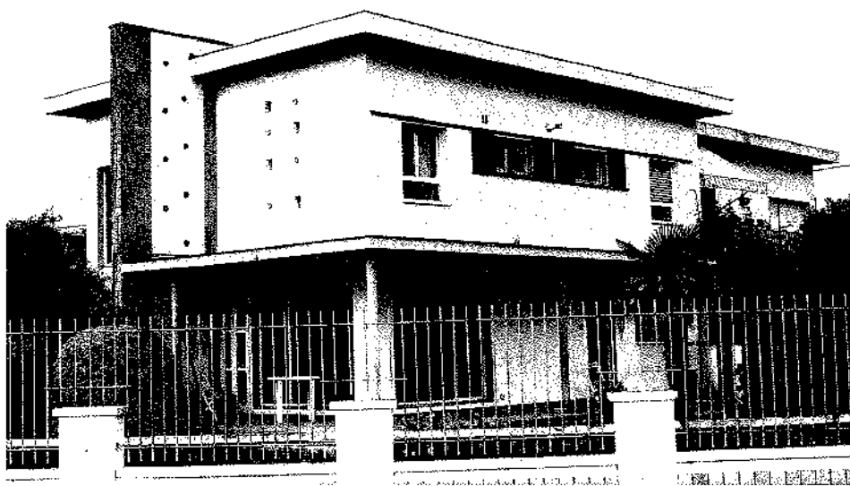
Vivienda funcionalista, con la característica cubierta plana de comienzos de los años 60
