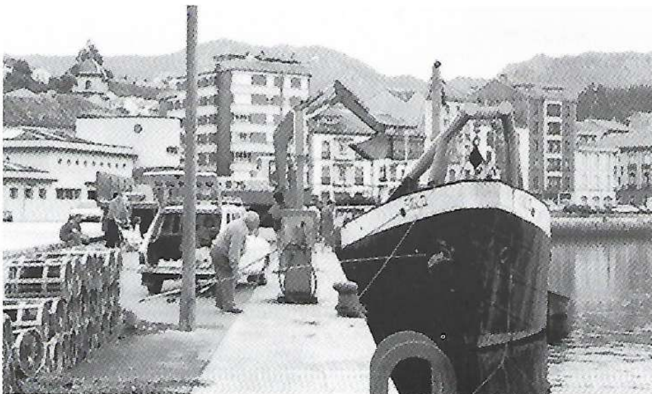
Barco utilizado para instalar el emisario submarino en Vega. Año 1989
