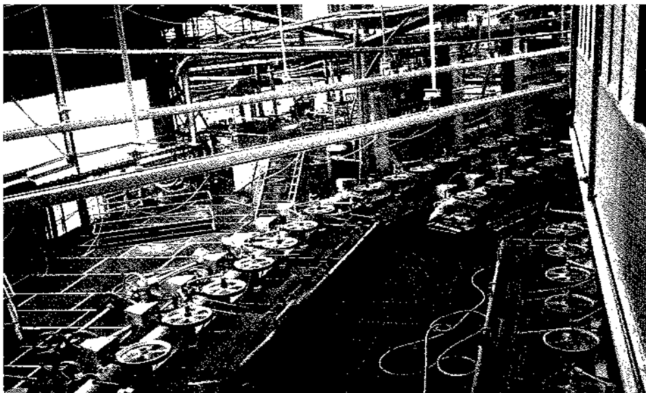
Lavadero de Torre. Cubas de flotación
