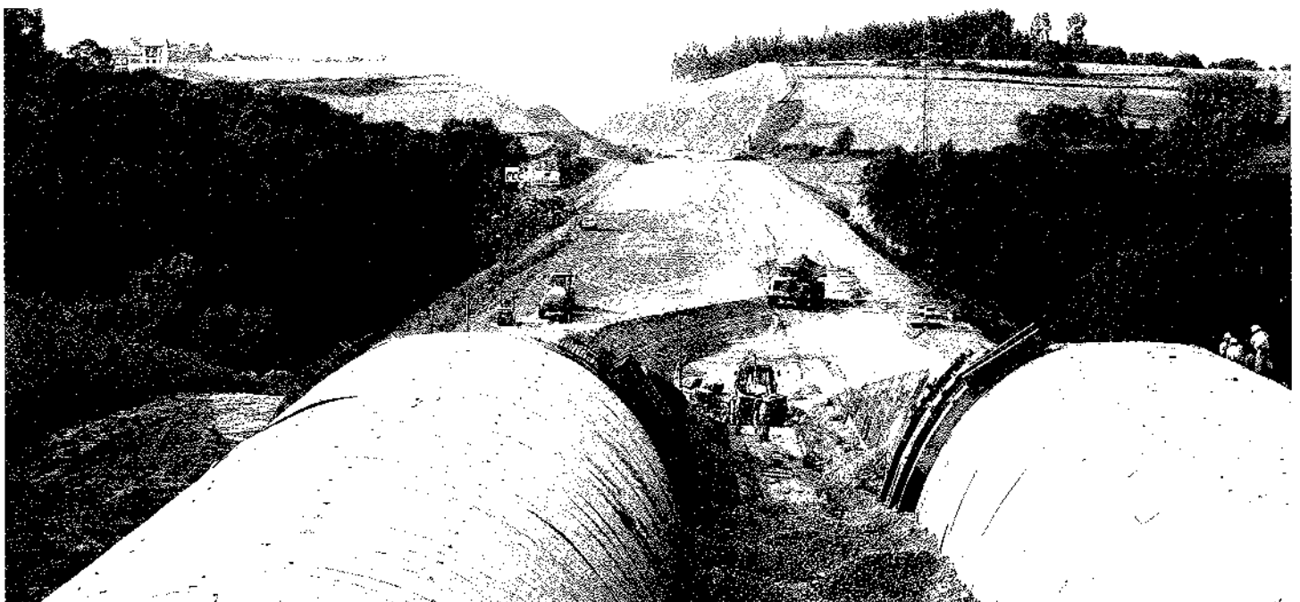
Obras de la autovía en Pando.
