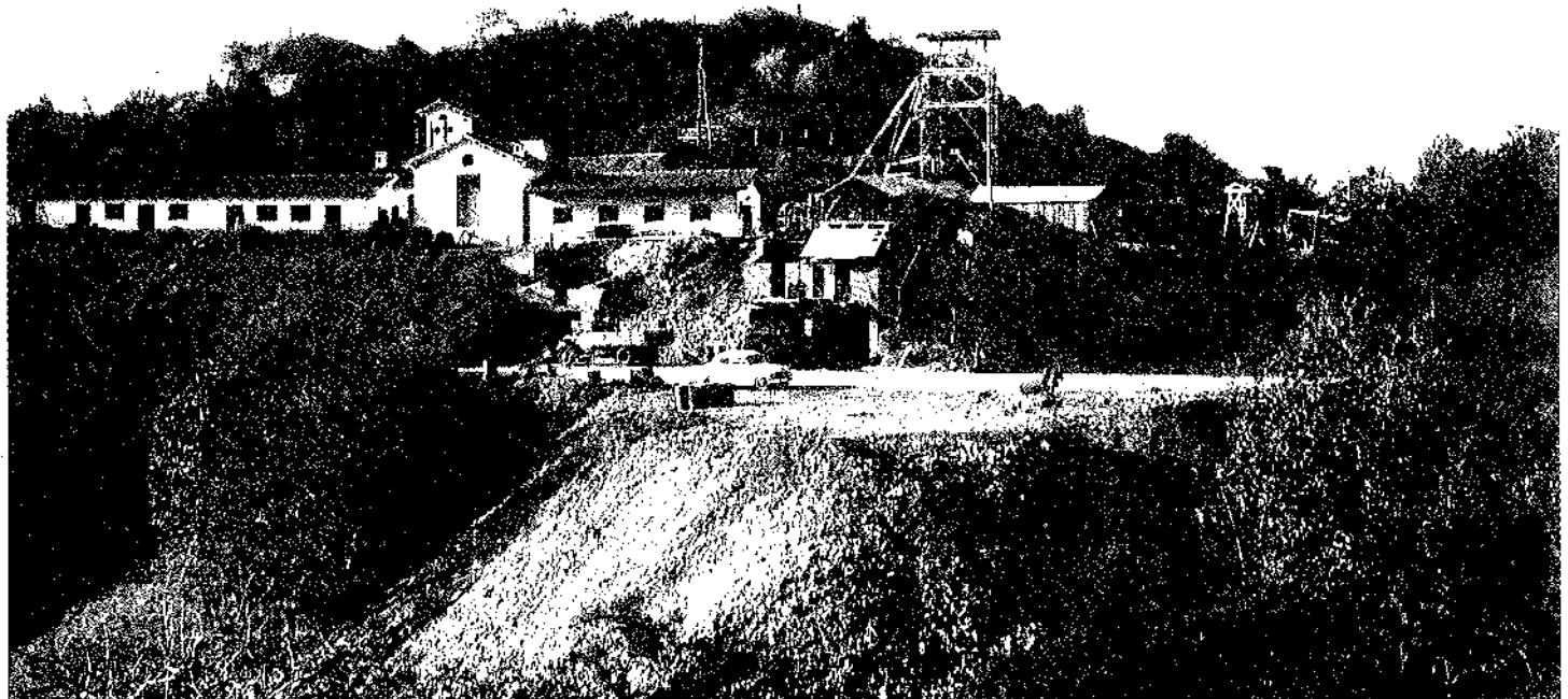
Antiguas instalaciones de la Mina "Ana" en noviembre de 1962. Foto cedida por J. Durán Zaloña para la revista "Bocamina". La escombrera del primer plano fue diseñada para contener los deslizamientos en la nacional 632 a su paso por Berbes.
