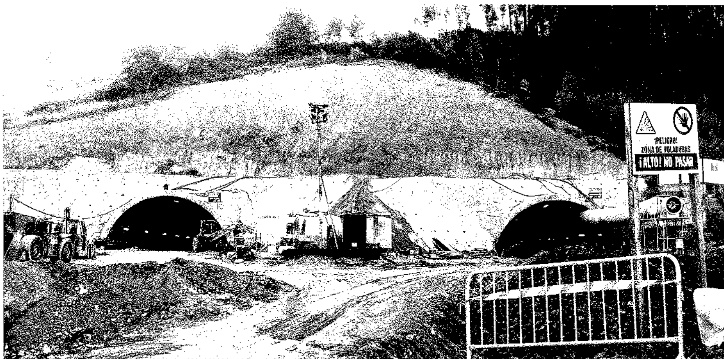
Obras en los túneles de Tezangos.
